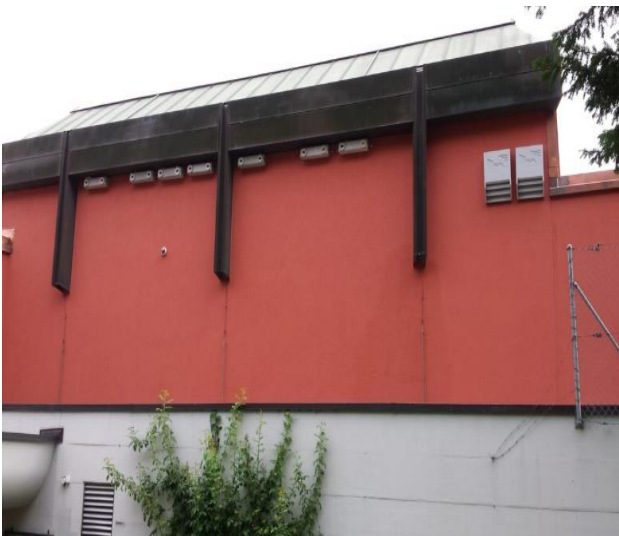
7 Doppelnistkästen für Mauersegler und 2 Behausungen für Fledermäuse stehen zum Bezug bereit. © Martin Preiswerk
